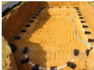
Mise en place des supports pour les panneaux (1)
