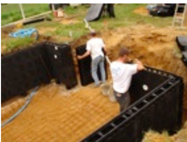
Montage de l'escalier (3)
