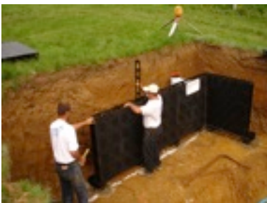
Mise en place des panneaux par une glissière (2)
